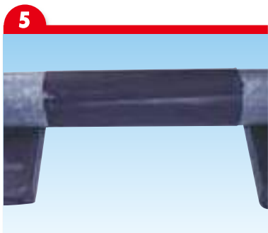
5 保護テープを剥がして完成。
