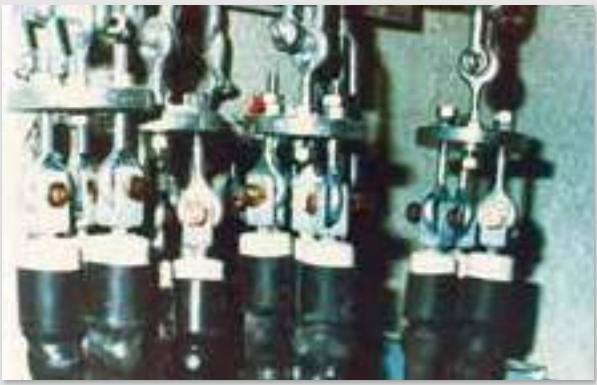
ビル用ケーブルの吊り下げ部(NPE)
