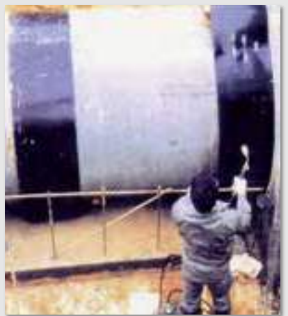
ヒューム管継手部防水 ニシチューブ(NXL-A)
