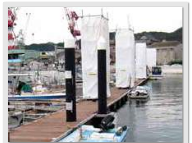
岡山県玉野市係留杭防食補修(NXL-A)
