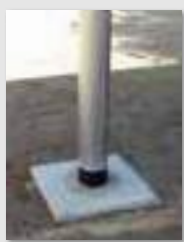
照明柱の地際防食事例(NPM-A)
