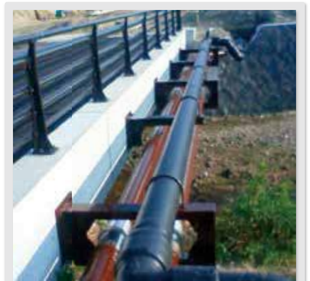
ポリエチレン製水道管の耐候性向上(NPE)
